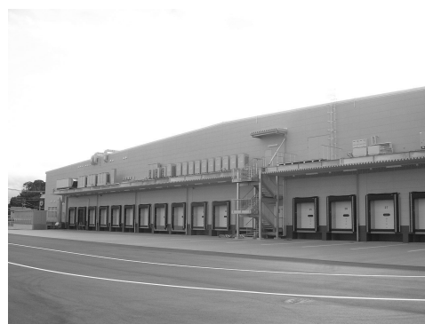
トラックが横付けされるバース
