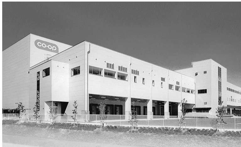
（コープネット事業連合会・印西冷凍センター 外観）
