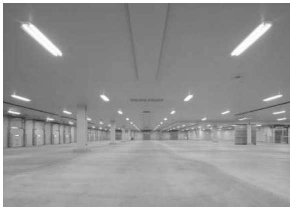
三温度帯対応の冷凍・冷蔵設備
