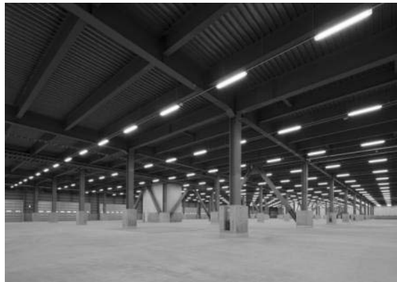
防火区画のない大空間
