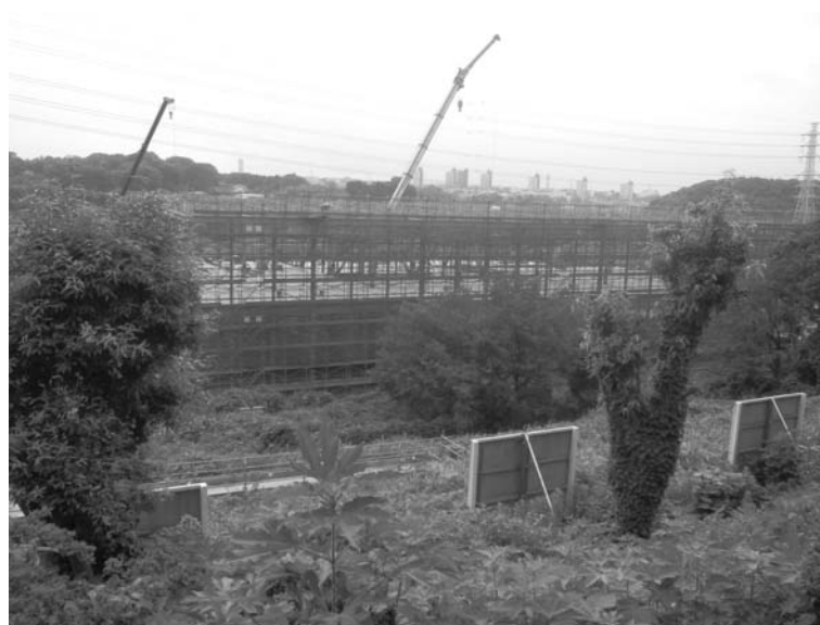
建築中の食品流通センター（仮称）
