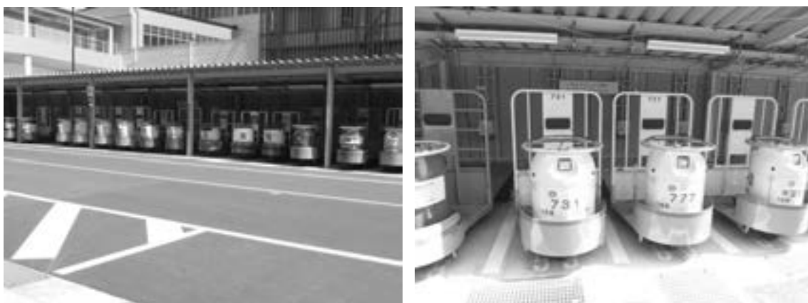
ターレットの共同充電設備
