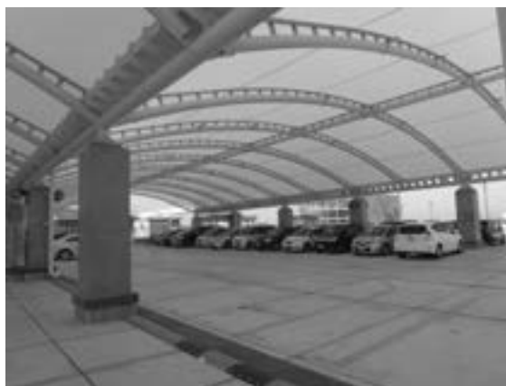
卸売場東棟屋上の通勤車両用駐車場
