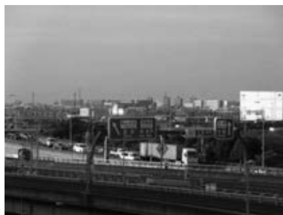
東京外環自動車道
