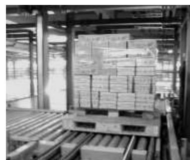
搬送コンベア
