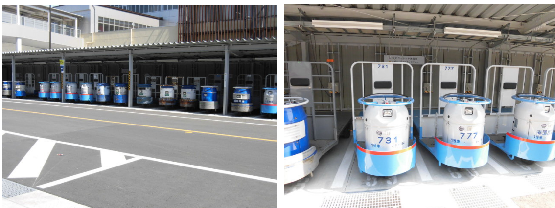
ターレットの共同充電設備
