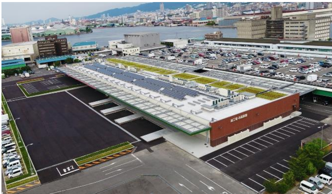
東部市場：加工場・冷蔵庫棟の外観
