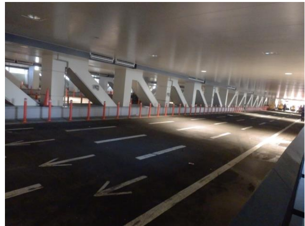
315号線下の約100m通路（6・7街区間通路）
