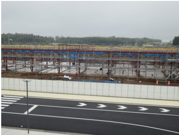
建設中の関連食品棟
