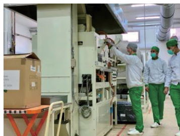
▲Maruzen Tea Moroccoに導入した火入れ加工設備
