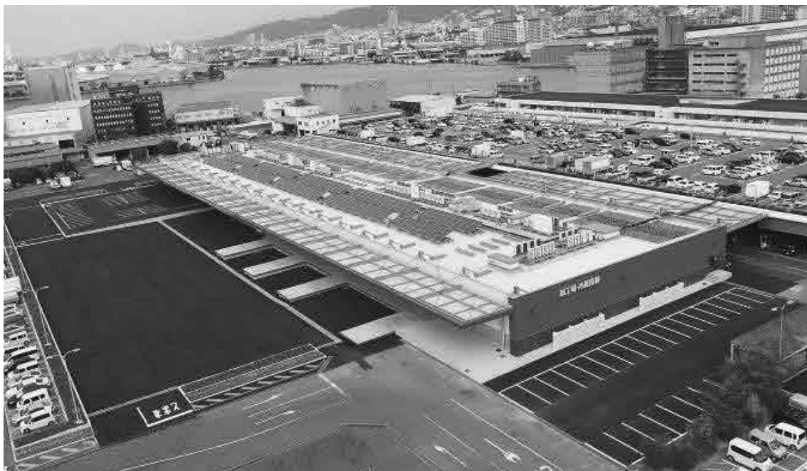
東部市場：加工場・冷蔵庫棟の外観
