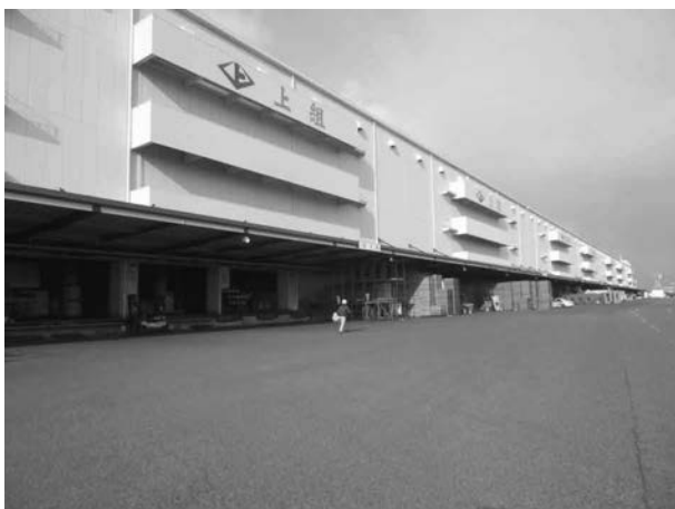
神戸港国際流通センターの外観
