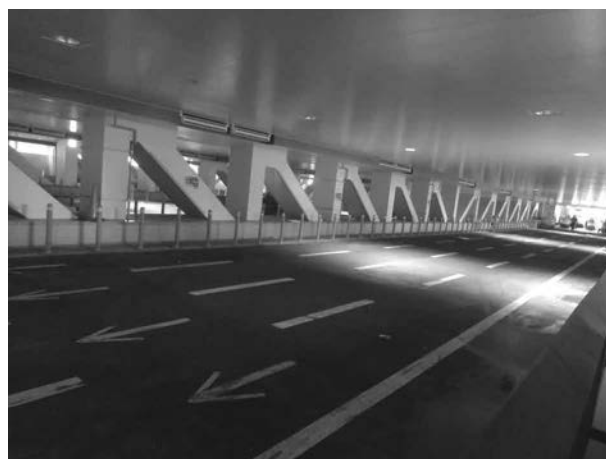
315号線下の約80m通路（6・7街区間通路）
