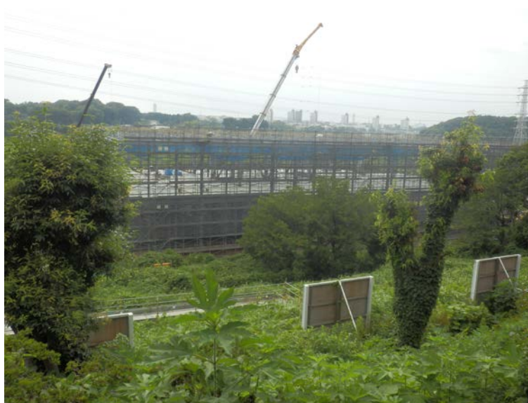
建築中の食品流通センター（仮称）
