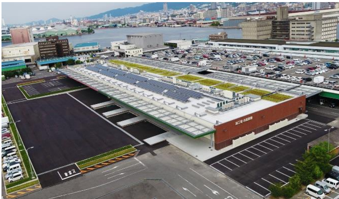
東部市場：加工場・冷蔵庫棟の外観
