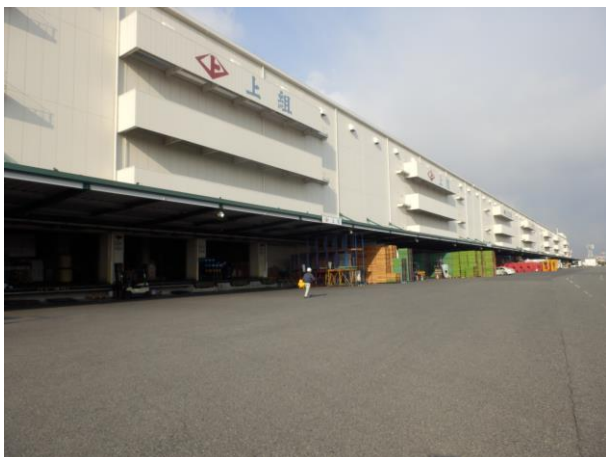
神戸港国際流通センターの外観
