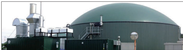
マヨネーズ残さをバイオガス発電する養豚農家さんの設備
